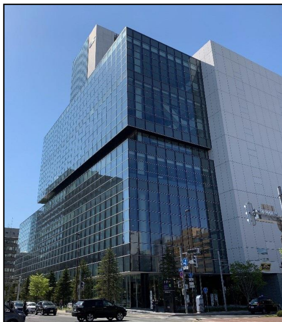
札幌市民交流プラザ外観
