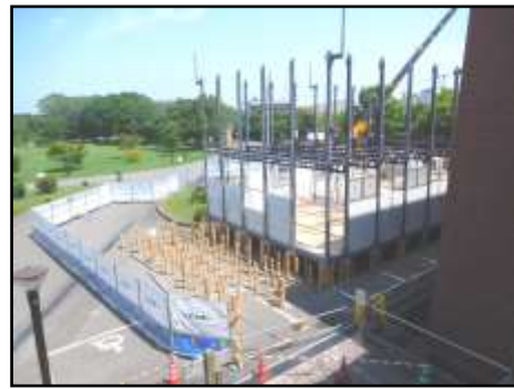
仮設庁舎建設 (H30. 7. 25)
