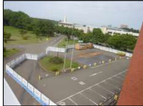
仮設庁舎建設仮囲い (H30. 7. 14)
