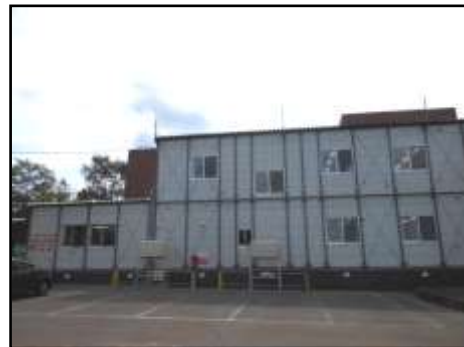
仮設庁舎完成 (H30. 8. 31)
